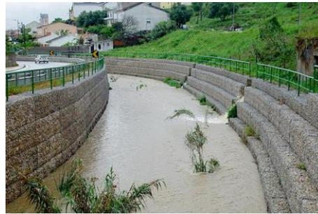
Figura 2: Gavión usado en control de río
