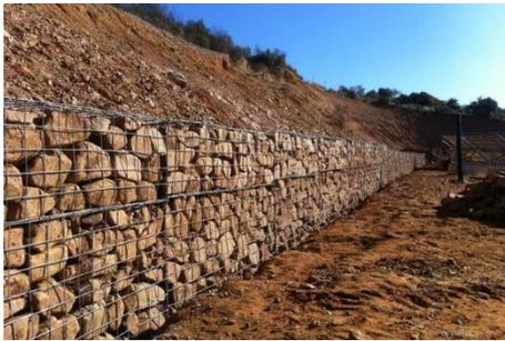
Figura 1: Muro de Contención con gaviones
